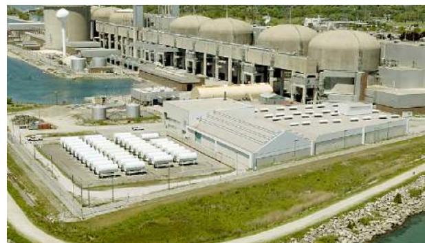
Рис. 8.2. Пикерингская установка по обращению с РАО (контейнерное хранилище элементов активной зоны реактора (слева), хранилище ОЯТ (справа))
