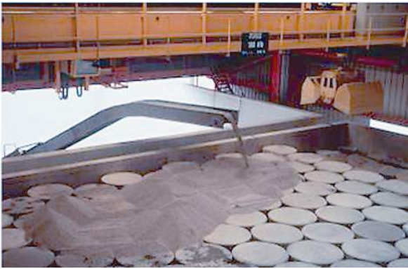
Рис. 11.12. Размещение контейнеров и канистр с РАО с использованием крана (слева) и заливка слоя цемента поверх металлических канистр с РАО (справа)
