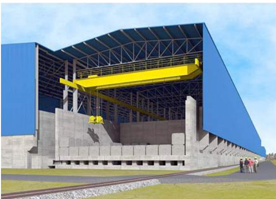
Рис. 2.4. Принципиальная схема приповерхностного пункта захоронения в Десселе
