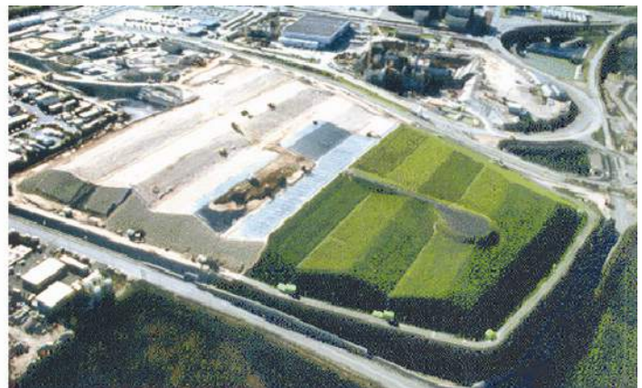
Рис. 11.8. Многослойное покрытие пункта захоронения Мани
