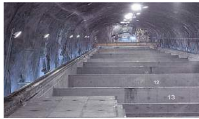
Рис. 13.5. Подземные выработки SFR: BTF, BMA, BLA (слева на право)
