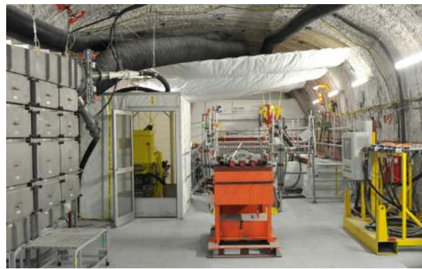
Рис. 5.10. Работы вблизи камеры 7 на глубине 750 м (Ассе II, 2012 год)
